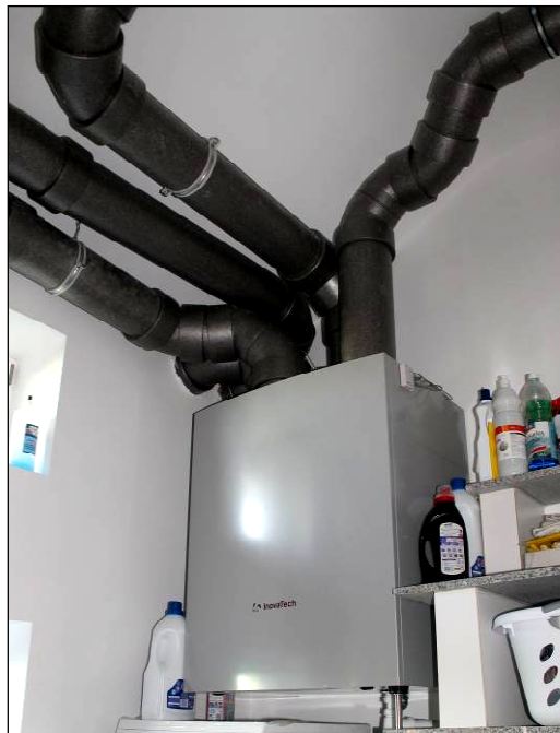
Figura 3: Unidad de recuperación de calor de VMC, Modelo Innoair 300 DC.
