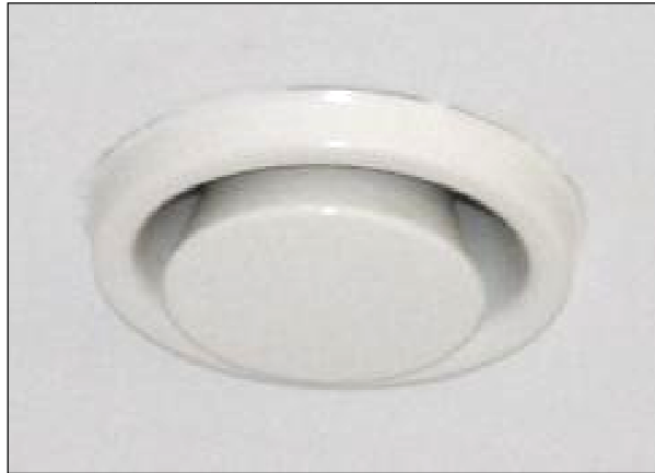
Figura 7: Detalle de la boca de extracción en locales húmedos.
