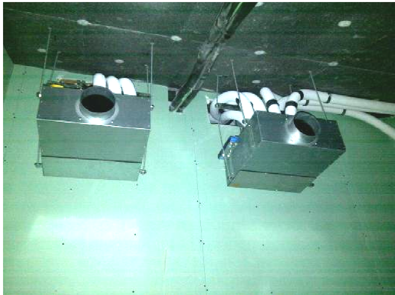
Figura 5: Detalle de colectores y derivaciones durante su instalación.
