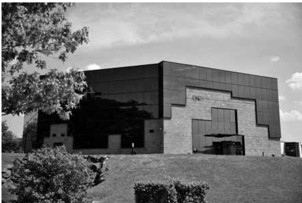
Edificio de ZIV en el Parque Tecnológico de Zamudio (Vizcaya).
