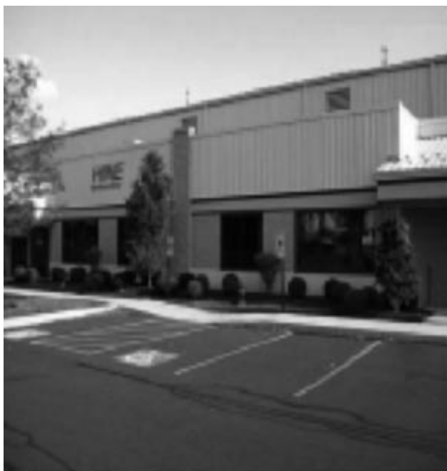
Vista de las instalaciones de HINE Hydraulics Corporation Inc.
