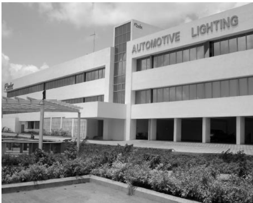
Segunda planta de Rinder en la India, situada en Chakan (2002).
