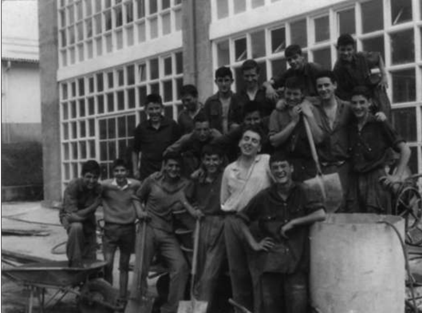
Foto 5. Voluntarios en la construcción del nuevo edificio del centro de formación. Finales de los años 50.
