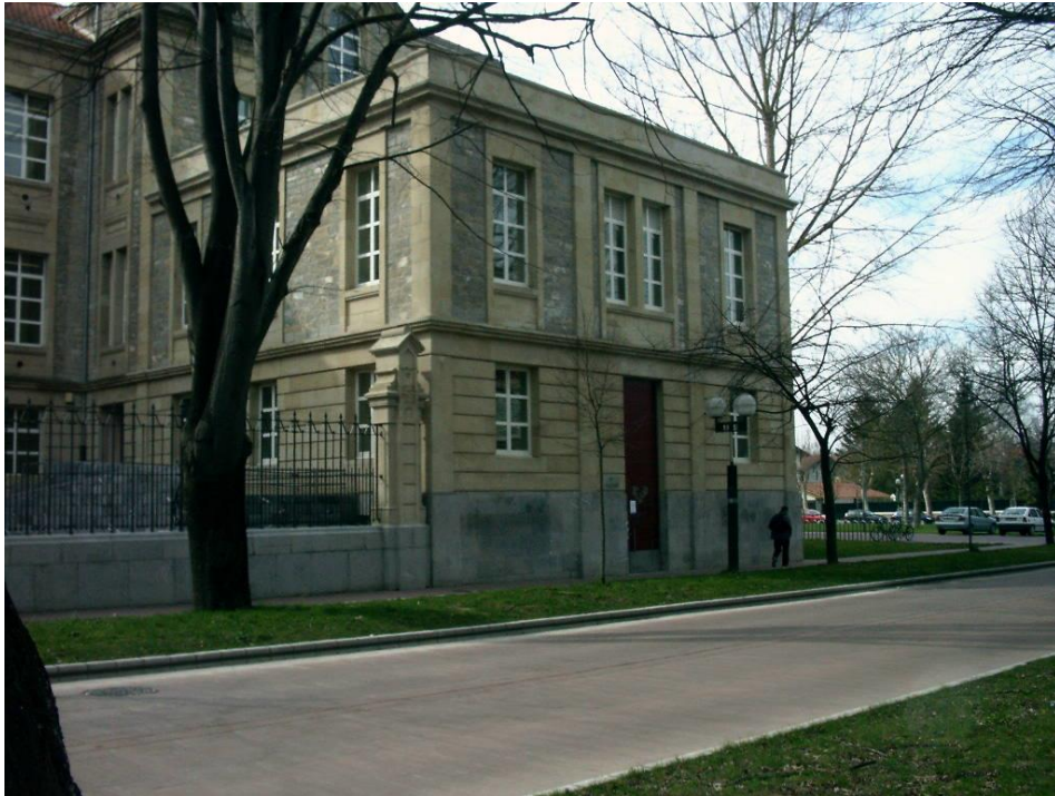
Vista general del Anexo de Institutos Universitarios
