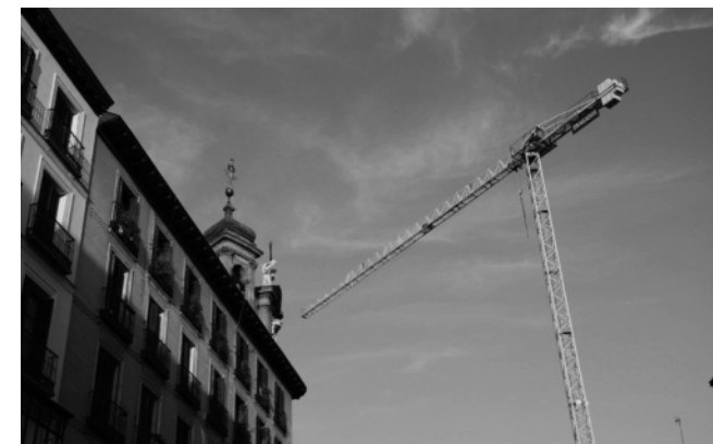
Nueva construcción en el casco antiguo de Madrid
