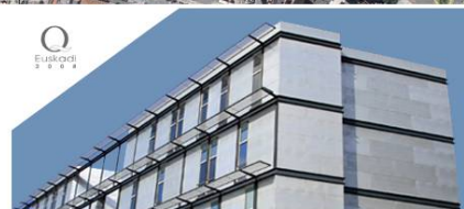
Bilbao ETS Ingeniería Edificio B
