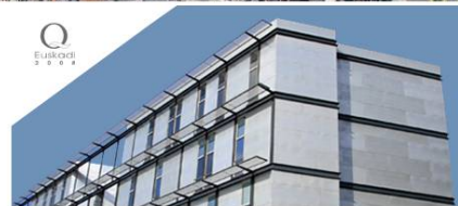
Bilbao ETS Ingeniería Edificio B
