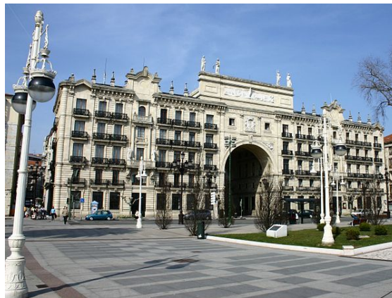
Edificio del Banco de Santander en la ciudad de Santander (España), de donde es originario y donde mantiene su sede social.
