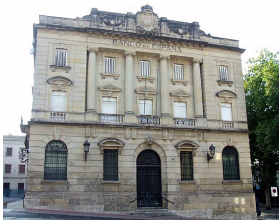
Edificio de la antigua sucursal del Banco de España en Vitoria.
