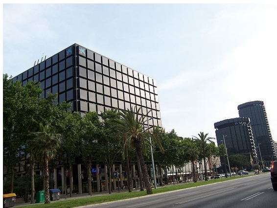
En primer término (edificio cúbico), la última sede de la hoy extinta Caja de Barcelona. Al fondo (torres cilíndricas) la anterior sede de la Caja de Pensiones, hoy sede de La Caixa.
