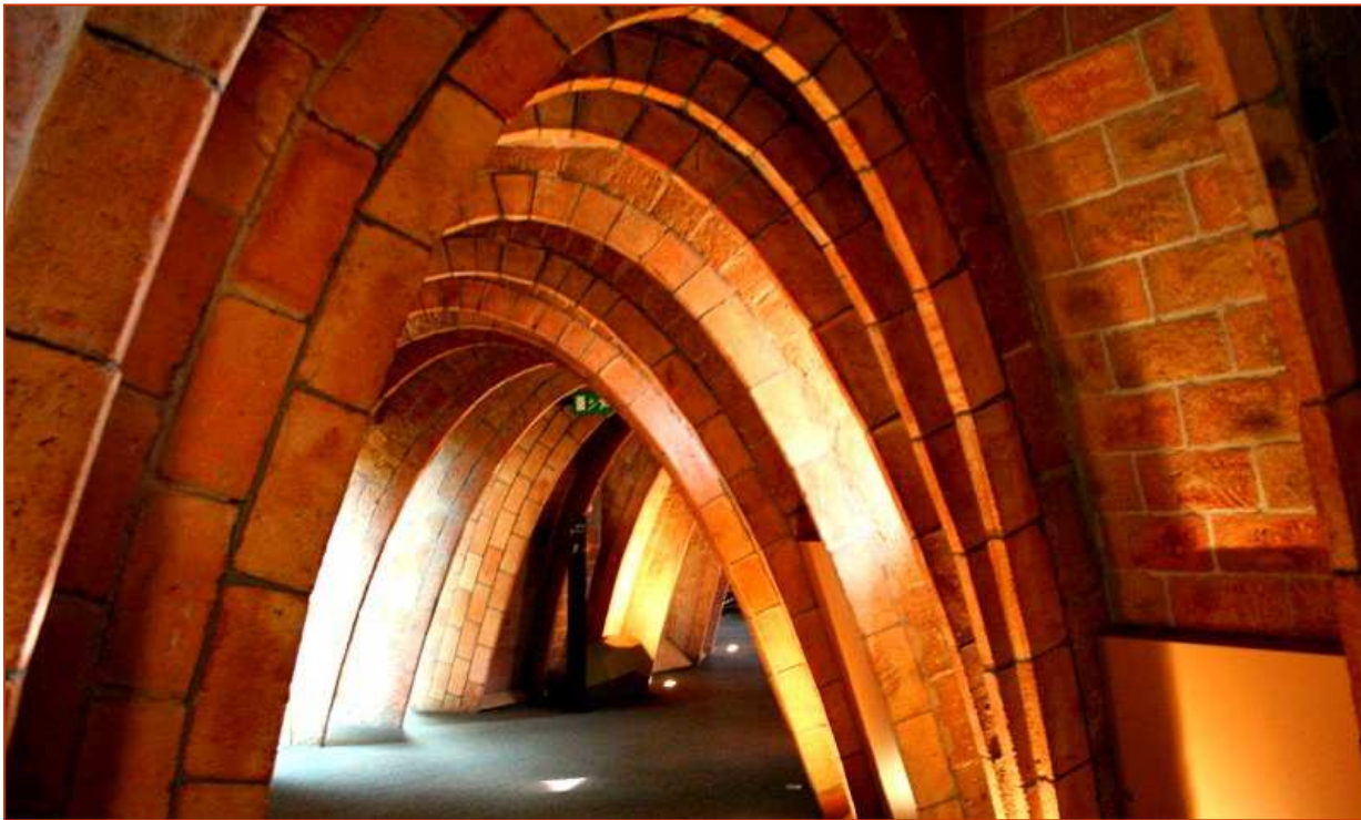
Parábolas en La Pedrera (Casa Milà) de Antoni Gaudí
